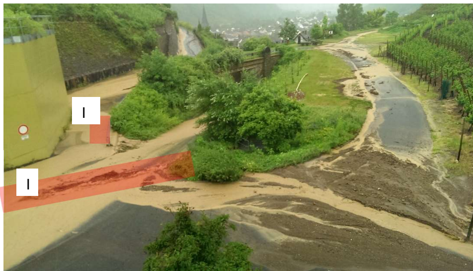
Abb. 2: Beispielanlagen in Dernau bei Starkregen (Bildquelle: M. Großgarten)
